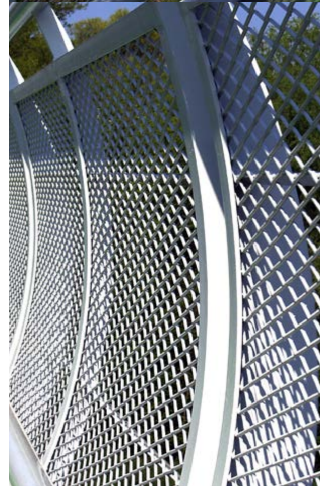
Použitý materiál: Výplň zábradlia Typ: ťahokov / kosoštvorcové oko MR 90 x 31,5 x 4 x 3 mm Materiál: žiarovo zinkovaná oceľ + farba
