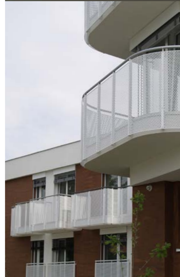
Použitý materiál: Výplň zábradlia Typ: dierovaný plech/kruhové otvory Rv 20 - 28 Materiál: pozink + farba
