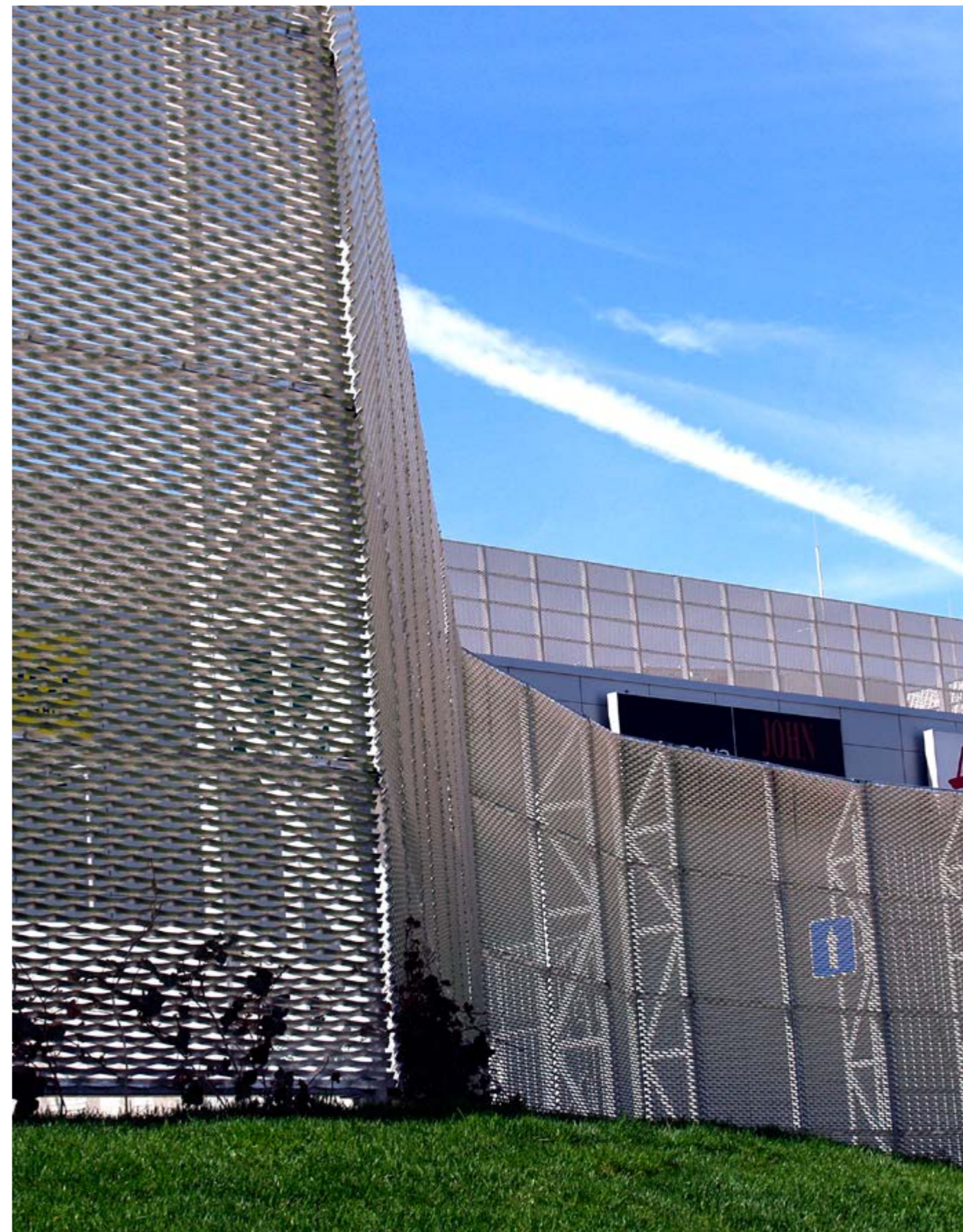
Použitý materiál: Oplotenie Typ: ťahokov/kosoštvorcové oko MR115 x 50 x 20 x 1,5 mm Materiál: hliník
