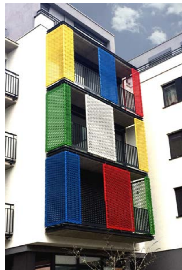
Použitý materiál: Tieniace panely Typ: ťahokov / kosoštvorcové oko MR 200 x 72 x 22 x 3 mm Materiál: hliník+ farba
