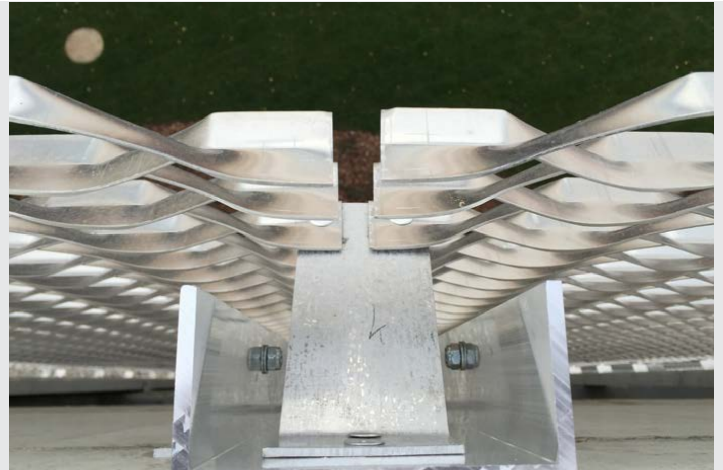
Použitý materiál: Fasáda Typ: ťahokov / šesťhranné oko ME 200 x 70 x 20 x 2 Materiál: hliník
